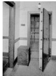
Die Lucky Town Bank erneuert ihre Sicherheitstüren.
